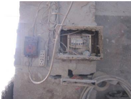
无盖的开关箱 Uncovered switch box.
