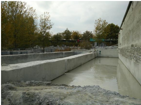
Wasserrecyclinganlage in ShanDong
