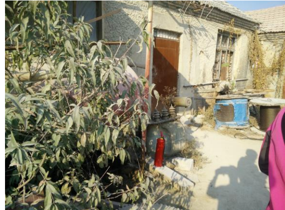
Fehlende Kennzeichnung und versteckte Positionierung des Feuerlöschers
