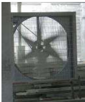
Der Staub wird mittels Ventilatoren aus der Produktionshalle geblasen und in außen liegende Setzbecken geleitet.
