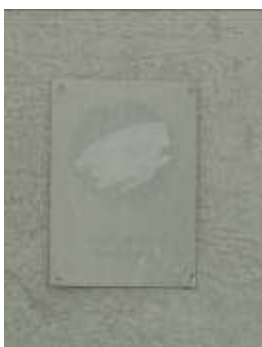
Dieses Hinweisschild ist stark verschmutzt und unlesbar.
